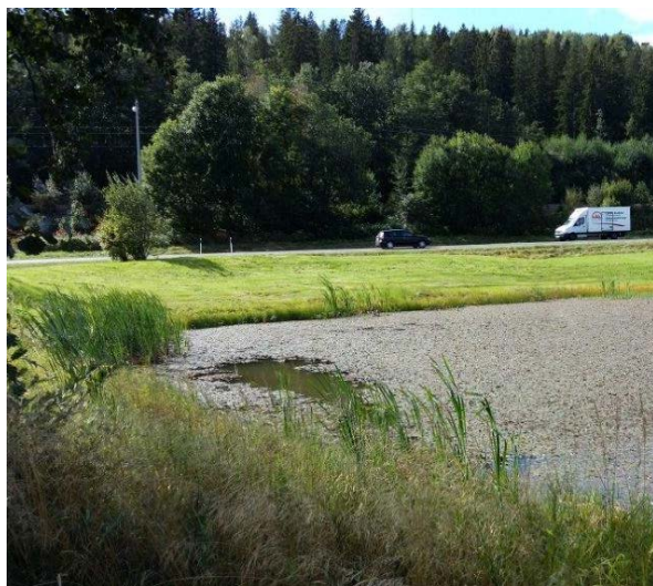
Dagvattendamm södra infarten
